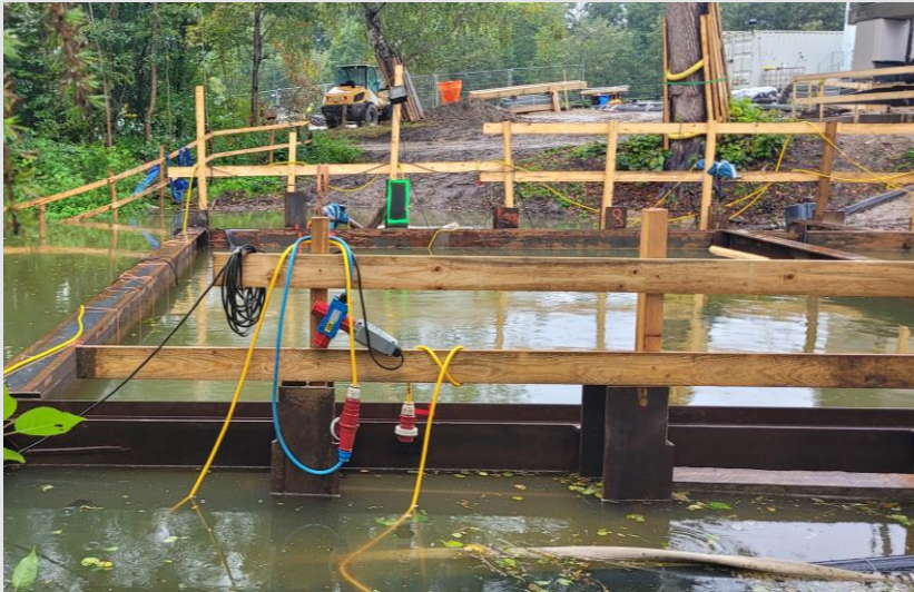
Baustelle an der Brandenmühle/Grinaw 20.10.2023
